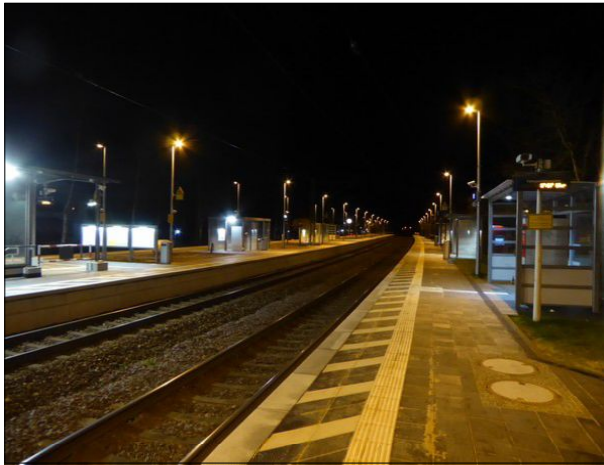
Abbildung 4: In Wrist sind die Bahnsteige erneuert worden. Auf jedem Bahnsteig wurde dabei auch ein zusätzlicher Unterstand aufgestellt.
