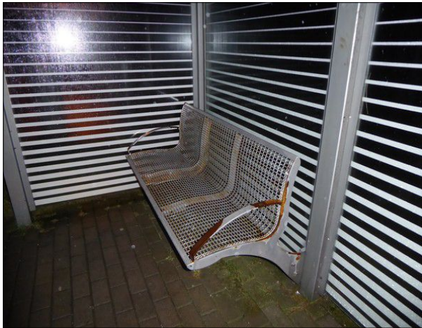
Abbildung 11: Die Zahl angerosteter Sitzbänke nimmt zu. An der Bank in Sandwehle ist die Korrosion schon umfangreich.
