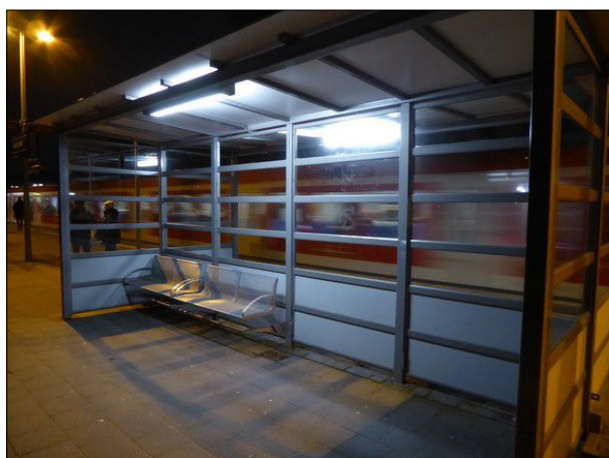
Abbildung 51: Die Fahrgastunterstände in Krupunder wurden mit Beleuchtung nachgerüstet.
