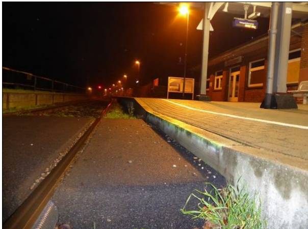
Abbildung 56: Die Anfang des Jahres 2015 bei der Erneuerung des Gleisüberwegs in Timmendorfer Strand eingebaute ca. 15 cm hohe Stufe an Gleis 1 wurde noch nicht beseitigt.
