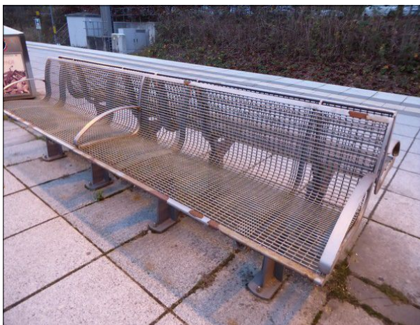
Abbildung 12: Fast alle Bänke in Aumühle weisen Lackschäden mit Rostbildung auf.
