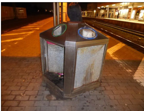
Abbildung 15: Dieser Behälter an den Gleisen 4/5 in Pinneberg muss ausgetauscht werden. Es fehlte eine Tür und er ist angerostet.
