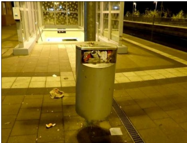
Abbildung 14: Sowohl im Gebäude als auch auf den Bahnsteigen (hier an Gleis 1) waren die Abfallbehälter in Bad Schwartau offenbar länger nicht geleert worden.
