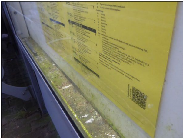
Abbildung 52: Die Vitrinen in Friedrichstadt waren vor allem an Gleis 2 innen stark verschmutzt.
