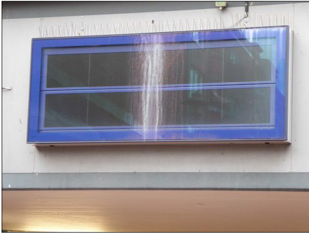
Abbildung 17: Die Abfahrtstafeln an den Tunnelzugängen in Elmshorn funktionierten nicht. Diese Tafel am Westzugang war zudem verschmutzt.
