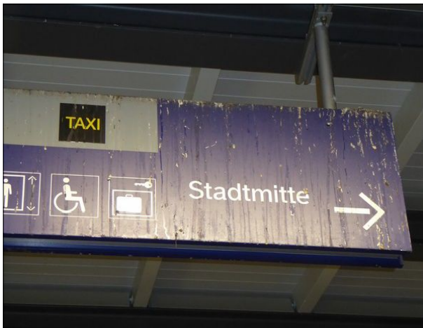
Abbildung 26: Die Wegeleitungsschilder in Neumünster sind teilweise erheblich durch Taubenkot verschmutzt.
