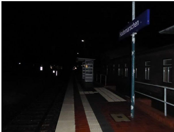
Abbildung 46: Auch vier Jahre nach Errichtung des Unterstands in Hademarschen funktionierte dessen Beleuchtung nicht. Durch den Defekt des daneben stehenden Lichtmasts war es auf dem Bahnsteig sehr dunkel.
