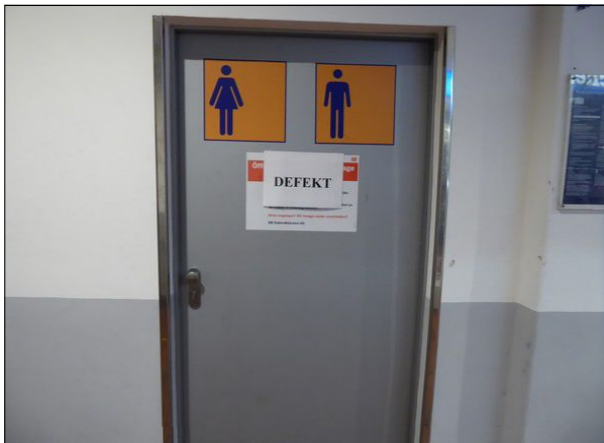
Abbildung 38: Der Hinweis auf die Schlüsselausgabe war auf der Eingangstür der Toilette in Itzehoe dieses Mal vorhanden. Leider war das WC defekt.
