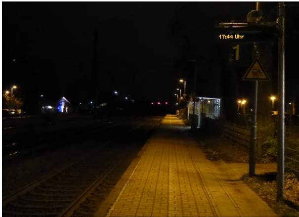
Abbildung 16: In Bargteheide wurde an Gleis 1 endlich ein zusätzlicher Schriftanzeiger installiert.
