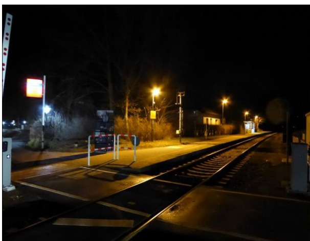
Abbildung 60: Beim Umbau des Bahnübergangs in Reinsbüttel musste auch der Stationsmast umgesetzt werden. Er ist auch am neuen Standort von der Straße aus gut zu erkennen.
