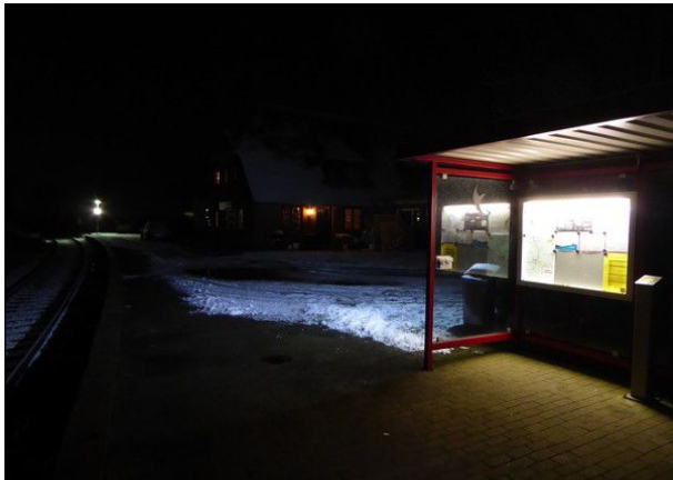
Abbildung 58: Durch einen am Unterstand montierten Strahler wurde die Beleuchtung des Bahnsteigs in Maasbüll etwas verbessert.
