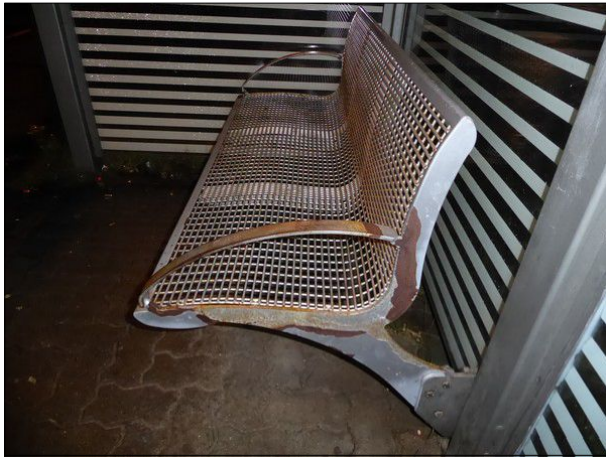
Abbildung 13: Die Sitzbänke an Gleis 2 in Bordeholm sind fast alle großflächig angerostet.
