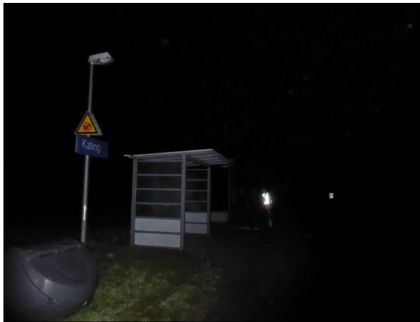
Abbildung 49: In Kating waren die Bahnsteig-, Unterstand-, Vitrinen- und Schilderbeleuchtungen ausgefallen. Nur der DSA funktionierte.
