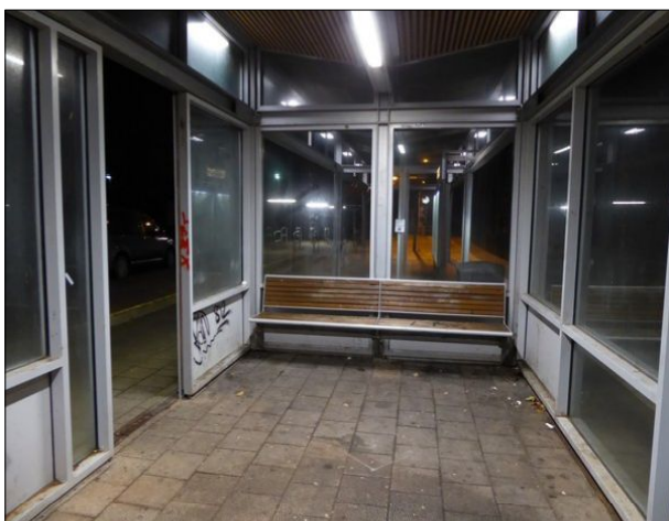
Abbildung 12: Neben groben Verschmutzungen der Brüstung und des Fußbodens der Wartehalle von Wahlstedt war auch hier aus dem Dach tropfendes Wasser festzustellen.
