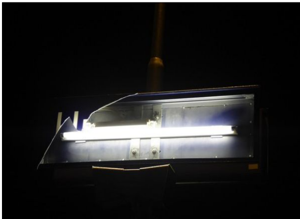
Abbildung 23: In Husum waren zwei Hauben der Bahnhofnamensschilder zerstört. Bei einem Schild funktionierte die Hinterleuchtung noch.
