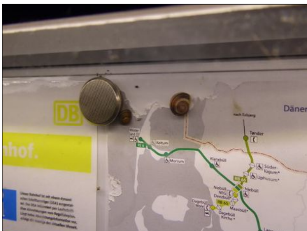
Abbildung 36: In den innen bereichsweise nassen Vitrinen in Wasbek lebten Schnecken, die die Aushänge fraßen.
